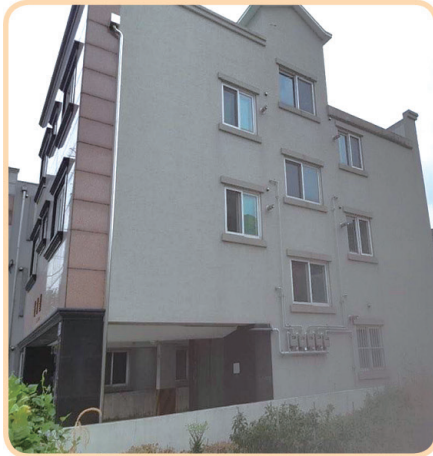
▼ 외벽 드라이버트 교체공사 (전)
