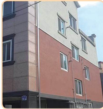
▼ 외벽 드라이버트 교체공사 (후)
