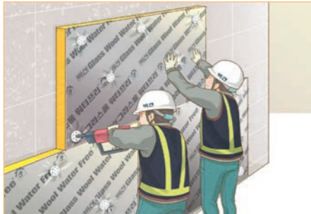
5 워터프리 막힌줄눈 시공
