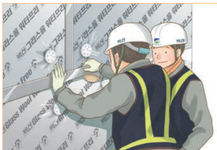
7 조인트 은박테이프 시공
