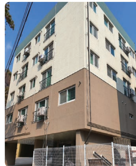
▲ LH 매입임대주택 화재안전 강화 보수 (파주 금릉동)
