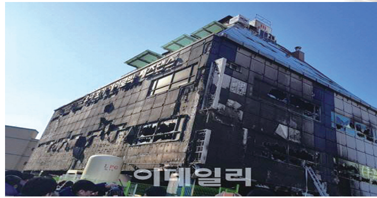
▶ 2017.12.21 충북제천 스포츠센터 화재사고 1층 주차장 필로티 배관 단열재(비드법보온판) 설치 중 불꽃으로 점화
