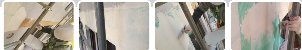
① 미네랄을 보드 부착 (창호 상부) ② 미네랄을 보드 표면 접착제 도포 (일액형 접착제 적용) ③ 접착제 시공면 유리섬유메쉬 함침 ④ 접착제 시공면 유리섬유메쉬 함침
