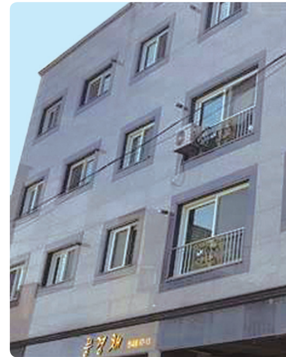
▲ 풍경채 (대전충남 LH임대주택 M/W외단열)
