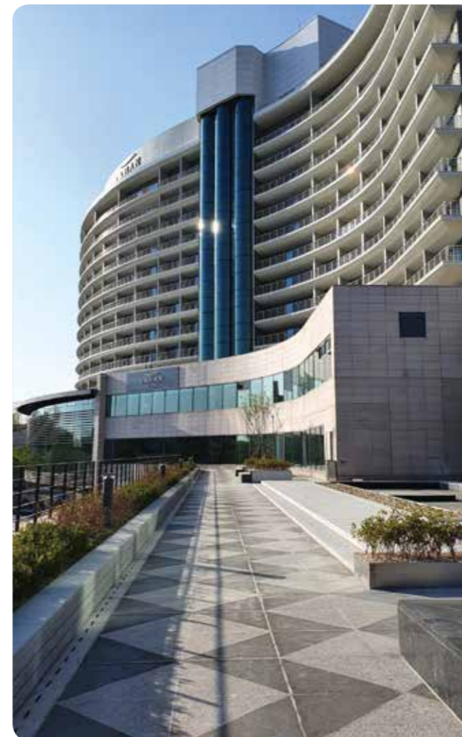
현 장 명 : 경주 라한호텔 적용부위 : 화장실 타일 하지재
