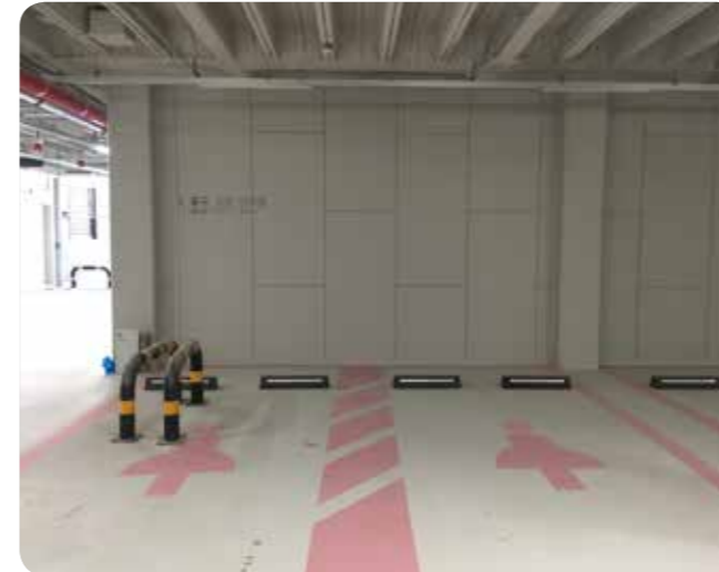
현 장 명 : 신라호텔 주차장 신축 적용부위 : 코어 및 램프 구간
