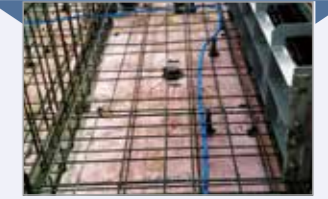
③ 철근 배근 및 콘크리트 타설
