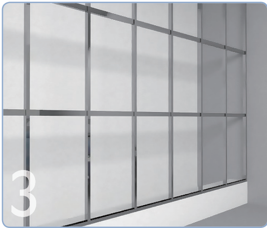
3 C-STUD에 Caring Channel을 3,000mm이내로 수평 설치한다
