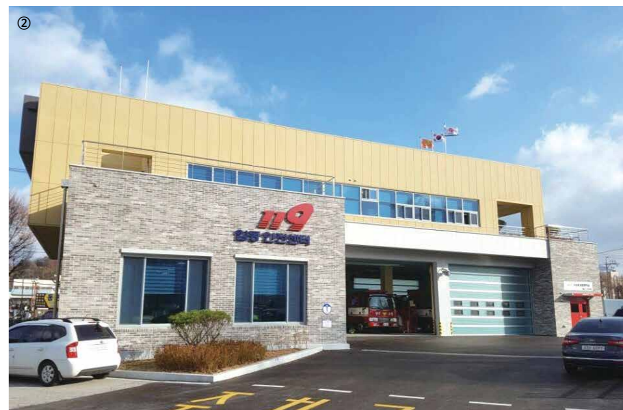
① • 공사명 : 부안 글로벌 청소년 리더센터 • 주소 : 전라북도 부안군 ② • 공사명 : 임동 119안전센터 • 주소 : 광주광역시 북구 서림로 5
