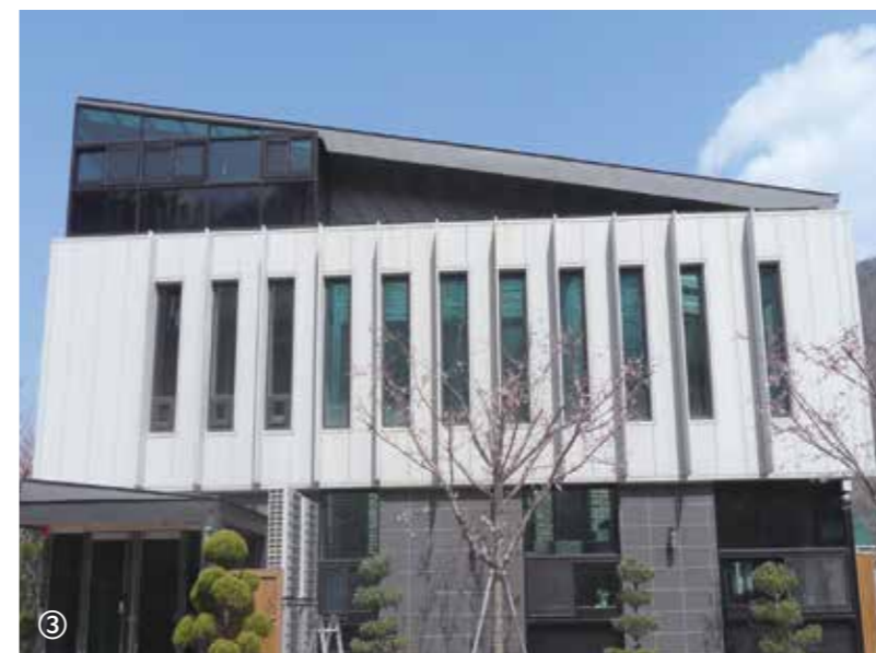
① •공사명: LG챔피언스파크 •주소: 경기도 이천시 대월면 대평로 255번길 69 ② •공사명: 임진각 곤돌라 승강장 •주소: 경기도 파주시 문산읍 임진각로 148-53 ③ •공사명: 김해 진례 청심 •주소: 경상남도 김해시 진례면 평지길 279-65
