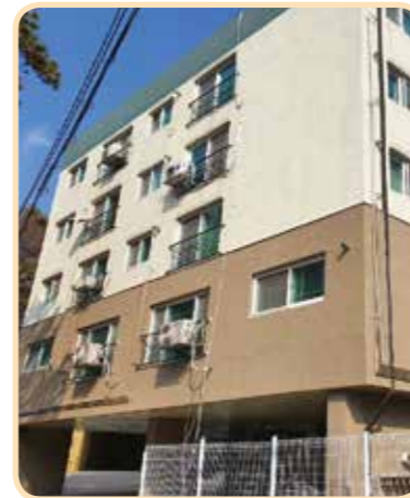
▲ 금릉동 빌라 (고양파주 LH임대주택 M/W외단열)
