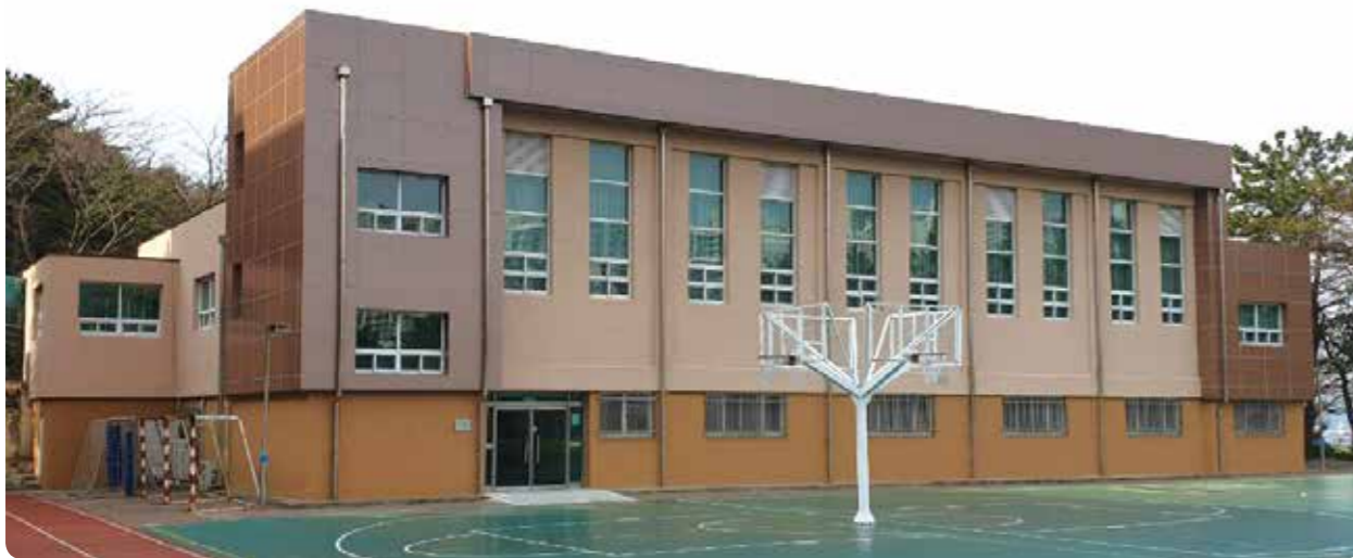
▲ 부산 해동중학교 다목적강당 외벽보수공사 미네랄을 외단열 시스템 공사
